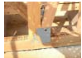
筋交いプレート (筋交いはずれ防止)
