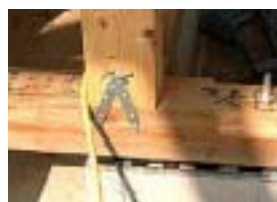
山形プレート (柱の引き抜き防止)
