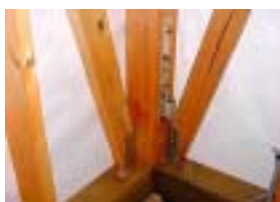
引き抜き金物 (柱の引き抜き防止)
